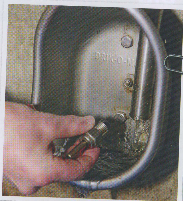
Terwijl het water loopt, schroeft Rob de nippels eruit. Ook tijdens het terugzetten van de nippel, vlak voor de opleg, blijft het water stromen om alles nog eens goed te spoelen.
